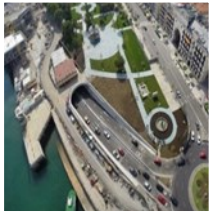
Túnel Centro Botín – Banco Santander (Santander)
